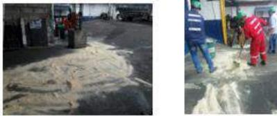
Foto No. 4: Acciones de control de contaminación, absorción y limpieza del área del derrame. (observarse la verificación de la afectación fuera del área (puerta de emergencia).
